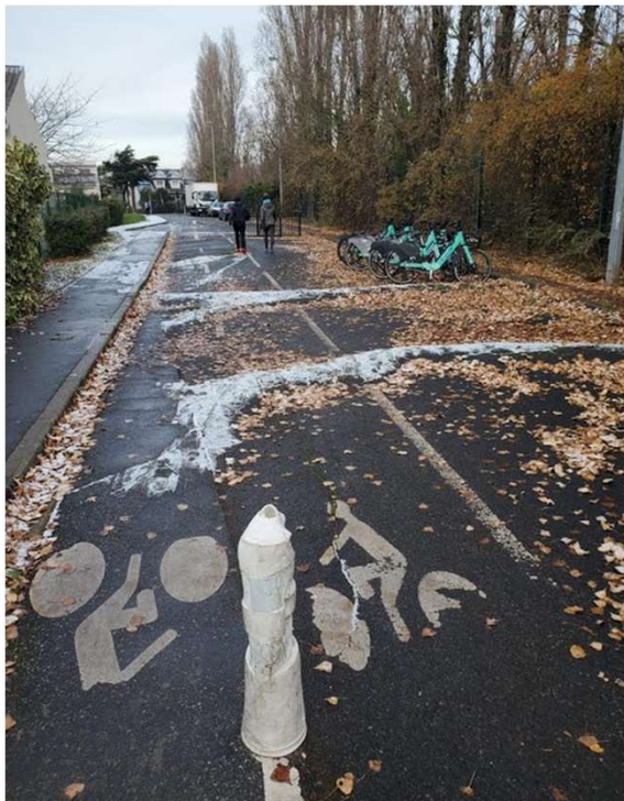
Routes cabossées pour le COLLÈGE => Janvier 2023 Projet en cours d'aplanissement
