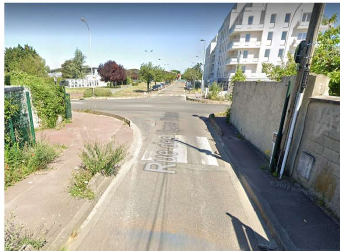
Croisement rue de vignes blanches (contre-sens cycliste) et D311 = ULTRA dangereux
