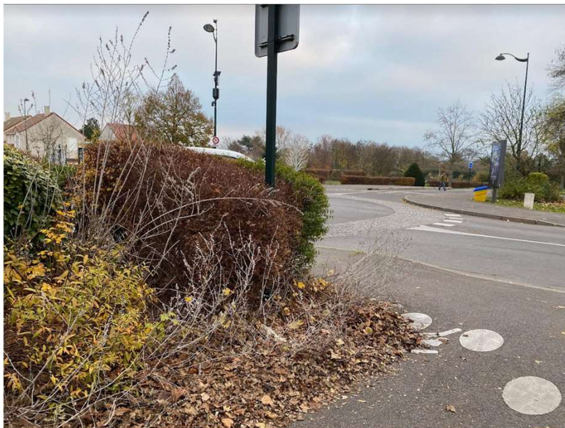
Feuilles mortes cachant le marquage au sol et glissantes
